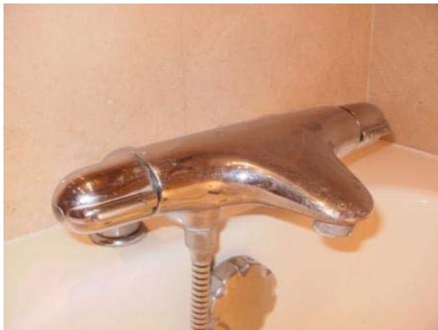
Un mitigeur thermostatique (voir exemple ci-dessus) est muni de deux commandes, l'une qui permet de choisir la température de sortie du mélange d'eau chaude et d'eau froide (*que l'on n'a donc plus en principe à modifier à chaque fois*) et l'autre le débit de l'eau.
