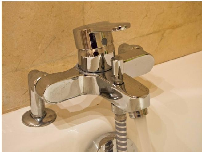
Ce mitigeur est équipé d'un seul levier qui permet, en le levant ou baissant de régler le débit de l'eau, et en le déplaçant vers la droite ou la gauche de doser le mélange d'eau froide et d'eau chaude.
