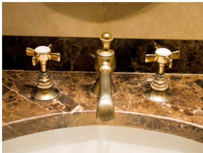
Ce type de robinet est muni de deux commandes distinctes, l'une pour l'eau chaude, l'autre pour l'eau froide, qui se mélangent dans une sortie unique.
